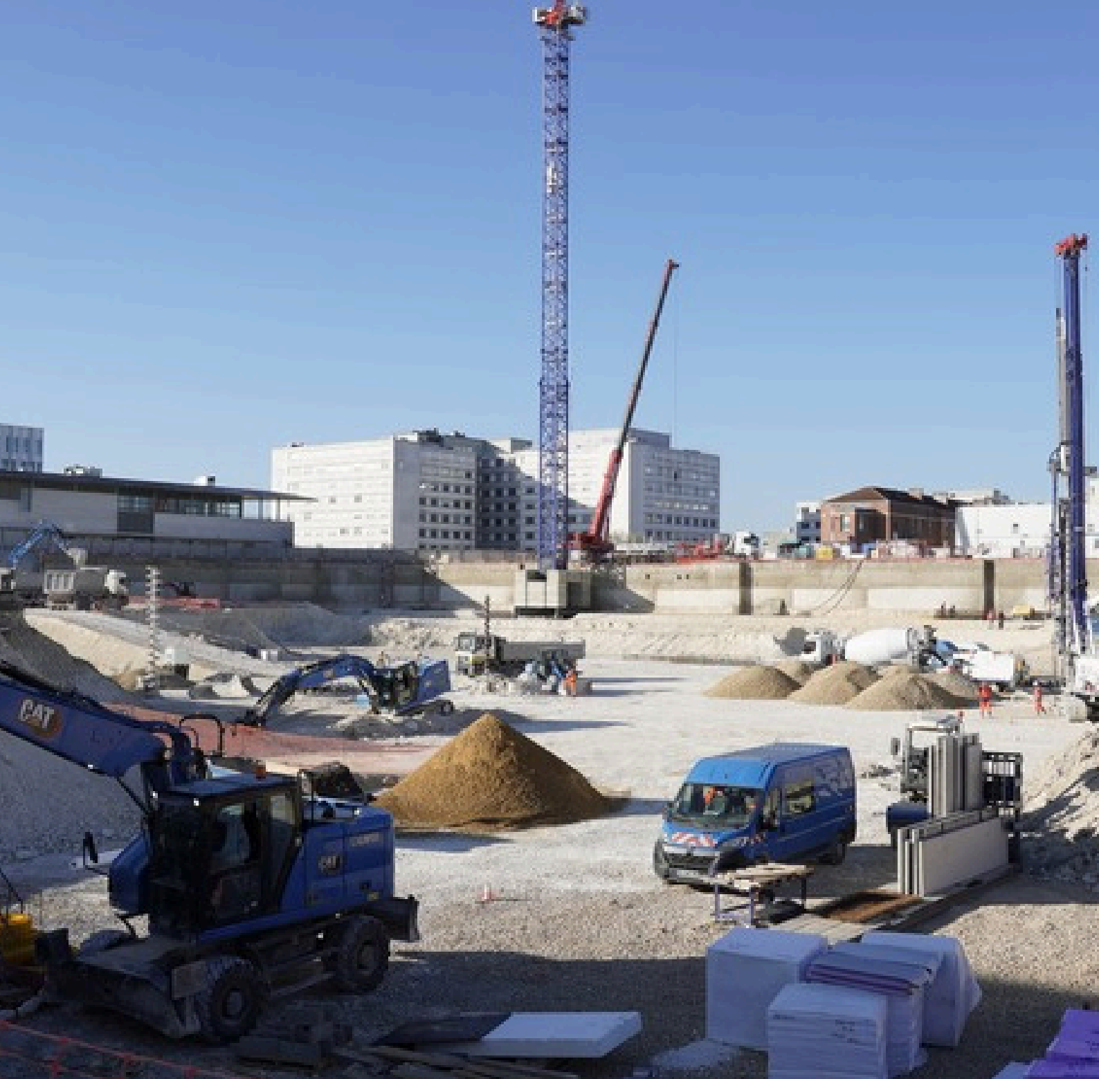
Chantier du bâtiment Madeleine Brès - Installation de la 1ère des cinq grues
