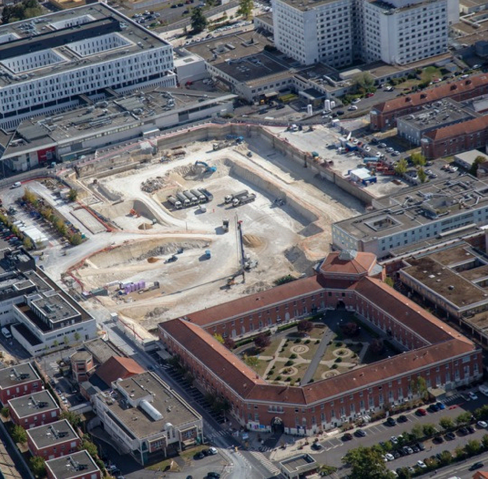
Vue aérienne - Chantier de la construction du bâtiment Madeleine Brès
